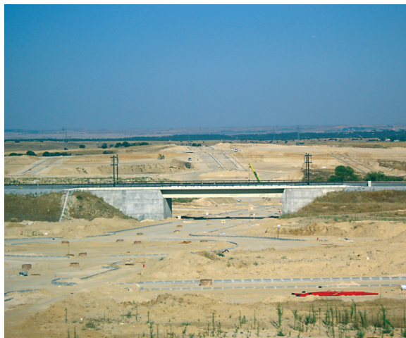
Figura 3.30. Los cambios en la planificación urbana pueden reducir o anular la efectividad de estructuras construidas para permeabilizar la vía, como ejemplifican estas dos estructuras, sobredimensionadas para la fauna por indicación de la Declaración de Impacto Ambiental, que pasan a tener una función urbana. Línea de Alta Velocidad Madrid-Valladolid a su paso por Tres Cantos, Madrid. Foto: TEG-UAM.
