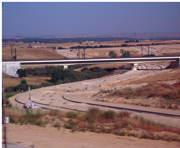
Figura 3.30. Los cambios en la planificación urbana pueden reducir o anular la efectividad de estructuras construidas para permeabilizar la vía, como ejemplifican estas dos estructuras, sobredimensionadas para la fauna por indicación de la Declaración de Impacto Ambiental, que pasan a tener una función urbana. Línea de Alta Velocidad Madrid-Valladolid a su paso por Tres Cantos, Madrid. Foto: TEG-UAM.
