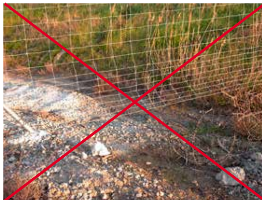
Figura 13.11. Malla sin enterrar que ha sido levantada por los animales. Foto: F. Navàs.
