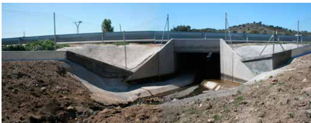
Figura 11.7. Cerramiento que conduce a los anfibios hacia un paso de fauna en construcción. Foto: Javier Cantero.
