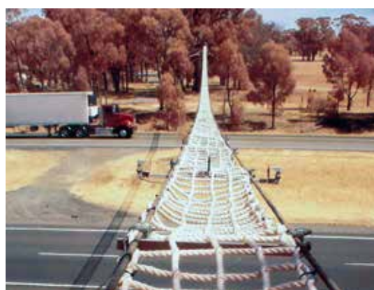
Figura 4.3. Paso de puente de malla. En zonas con alto riesgo de incendio forestal es indispensable el uso de materiales ignífugos para evitar la propagación de fuego. Foto: Kylie Soanes.
