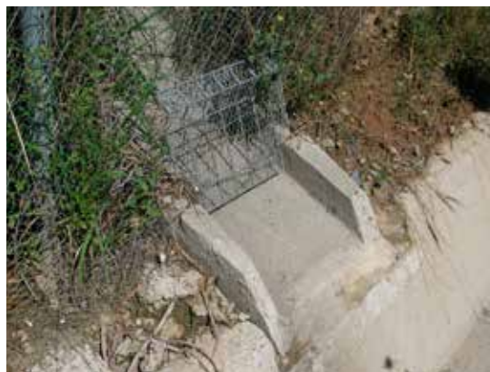
Figura 13.9. Dos alternativas de sistemas destinados a impedir el paso de animales por los puntos de intersección del cerramiento con las cunetas de drenaje perimetral. Fotos: Minuartia.
