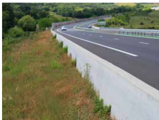
Figura 11.5. Cerramiento opaco de hormigón que constituye una óptima estructura de guía. Foto: C. Rosell.
