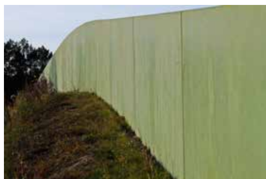
Figura 1.7. Las pantallas de madera tratada o placas de hormigón tintado requieren menor mantenimiento que la vegetación. Foto: C. Rosell.
