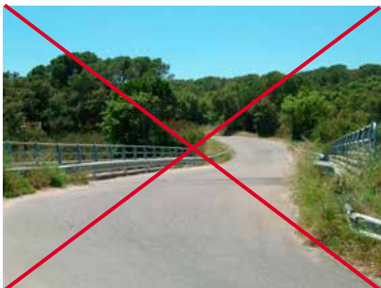
Figura 3.5. Paso que podría haber sido acondicionado para la fauna colocando pantallas de madera y revegetando las franjas laterales. Foto: F. Navàs.
