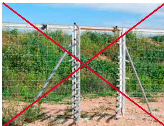
Figura 15.10. El diseño de este portillo de escape para ungulados posibilita que se mantenga completamente abierto permitiendo el libre acceso de animales (y personas) al interior del vallado. Fotos: F. Navàs.
