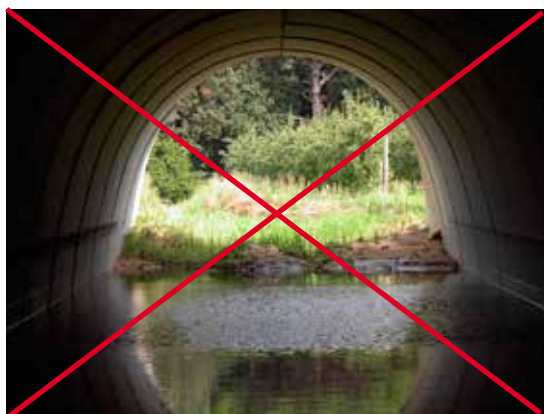
Figura 6.9. La inundación completa de la base de la estructura dificulta el paso de la fauna. Foto: C. Rosell.
