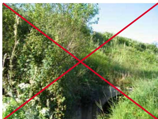
Figura 12.8. La existencia de franjas de vegetación conectando el hábitat de los márgenes del curso de agua hasta la calzada facilita la conducción de los animales hacia esta, aumentando la probabilidad de atropello. Foto: F. Navàs.
