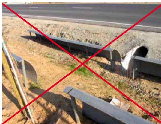
Figura 11.11. Discontinuidad entre distintos tramos de la vallas de guía. Foto: F. Navàs.
