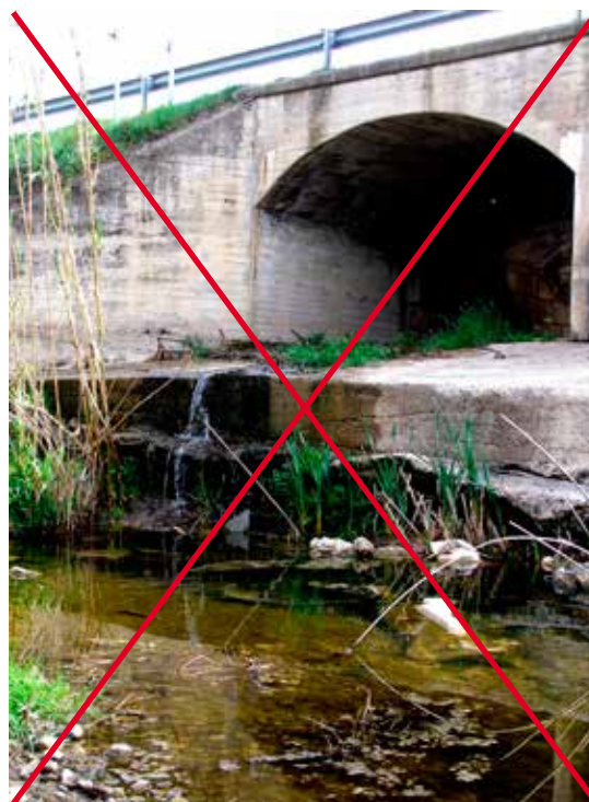
Figura 10.5. Socavación de la base de la estructura que ha generado un desnivel insalvable para la fauna acuática. Foto: M. Clavero.
