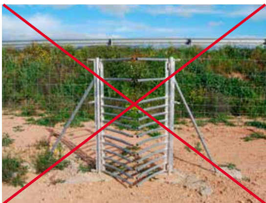
Figura 15.10. El diseño de este portillo de escape para ungulados posibilita que se mantenga completamente abierto permitiendo el libre acceso de animales (y personas) al interior del vallado. Fotos: F. Navàs.
