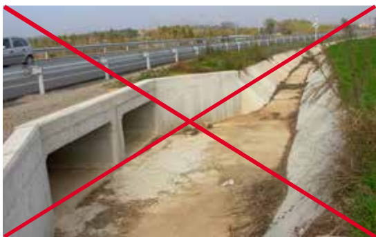
Figura 9.9. Las paredes de la acequia dificultan el retorno de los animales al entorno. Foto: F. Navàs.
