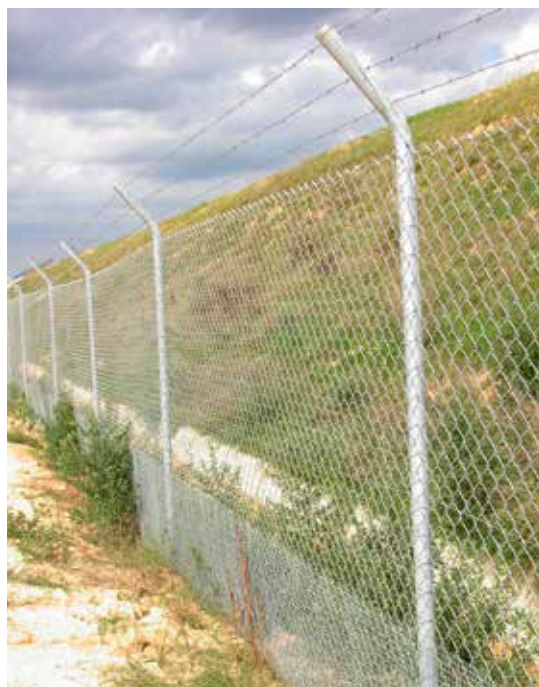
Figura 14.3. Cerramientos que combinan prolongación para impedir el salto de cérvidos y refuerzo basal para pequeños vertebrados. Foto: M. Fernández Bou.
