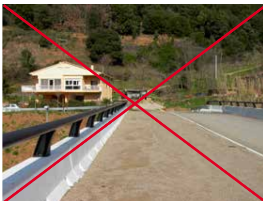
Figura 3.6. La franja lateral destinada a la fauna debería estar cubierta de tierras pero en este caso se han utilizado gravas. Además, la ubicación es poco adecuada debido a la proximidad de edificaciones. Foto: F. Navàs.
