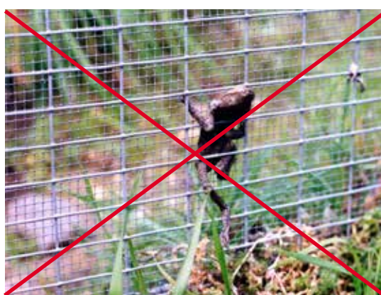
Figura 11.13. Las mallas de alambre galvanizado no son aplicables porque los anfibios intentan trepar por ellas. Foto: R. Campeny.
