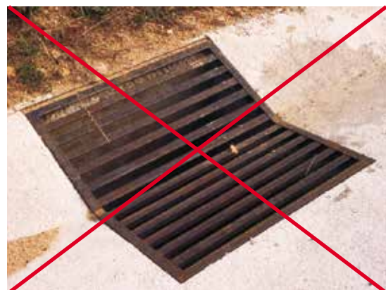
Figura 20.5. Las rejillas protectoras de pozos o arquetas deben ser densas para evitar la caída de pequeños animales en su interior. Además es preferible que las paredes de estos se adapten para facilitar la salida de animales. Foto: C. Rosell.
