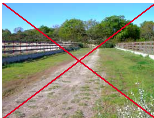
Figura 2.8. Circulación motorizada por un paso superior específico para la fauna y pantalla lateral que no es completamente opaca. Foto: C. Rosell.
