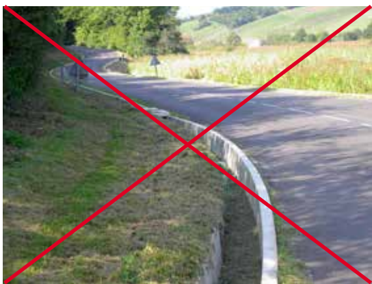
Figura 11.12. Las zanjas de recogida de anfibios que los conducen a entradas de pasos ubicadas en su interior, constituyen trampas para animales de pequeño tamaño. Foto: C. Rosell.
