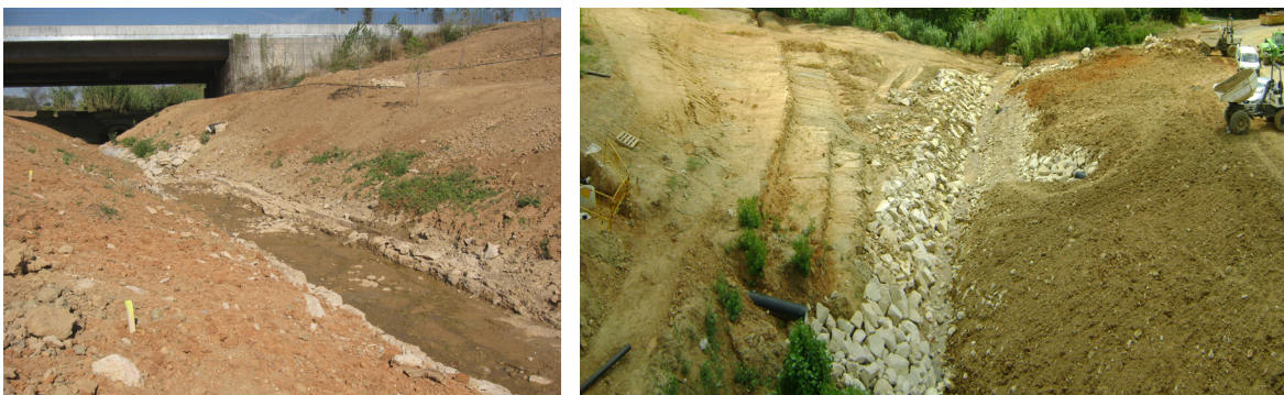
Figura 4 Llera restituïda del torrent del Bosc.. A la foto de l' esquerra estat de la llera restituïda sota el viaducte de la carretera BP-1413. En la foto de la dreta l'estat de la llera restituïda aigües avall del viaducte i abans de la seva afluença a la riera de Sant Cugat. Fotos: Consorci Centre Direccional
