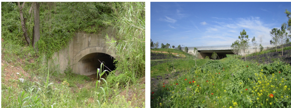
Figura 2 Carretera BP-1413 al torrent del Bosc. A la foto de l'esquerra (al fons) s'observa la volta de 3 m d'amplada existent abans de l'execució de les obres previstes en el projecte del Corredor Verd. A la dreta s'observa vista general del viaducte de 30 m d'amplada existent en l'actualitat. Fotos: Minuartia.
