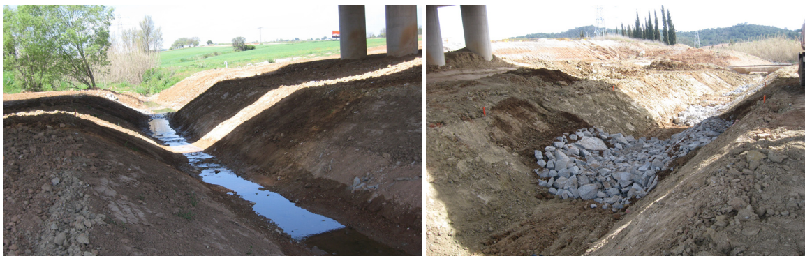
Figura 3 Llera del torrent de Can Fatjó sota el viaducte de la carretera BP-1413 . A dalt secció longitudinal de la llera sota el viaducte. A la foto de l'esquerra s'observa la secció de la llera restituïda i en la foto de la dreta l'execució de la protecció realitzada. Fotos: Consorci Centre Direccional
