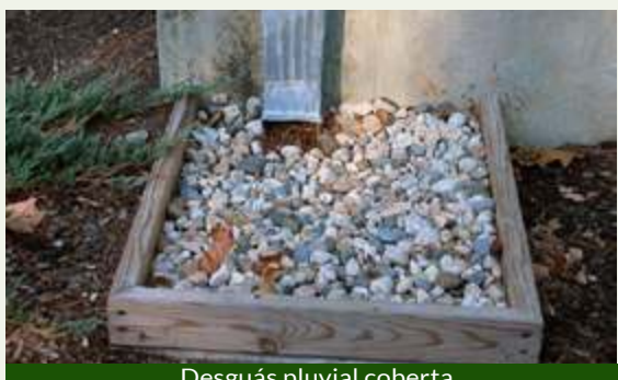
Desguàs pluvial coberta
