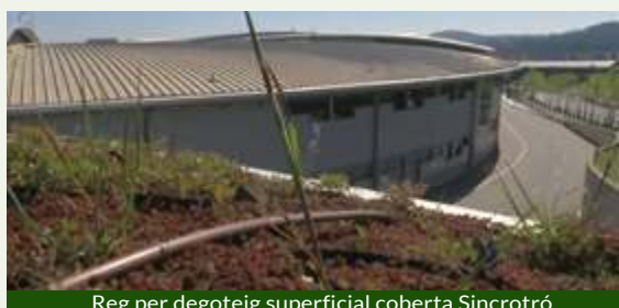
Reg per degoteig superficial coberta Sincrotró
