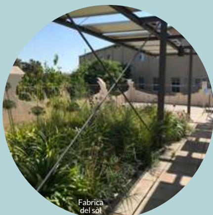
Coberta intensiva amb múltiples usos
