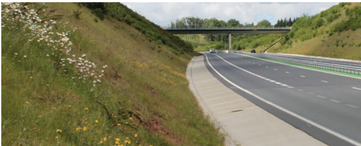
Figura 5.2. La pavimentación de las cunetas y los taludes con vegetación poco atractiva para los animales puede contribuir a reducir la mortalidad por atropello. Foto: Minuartia.
