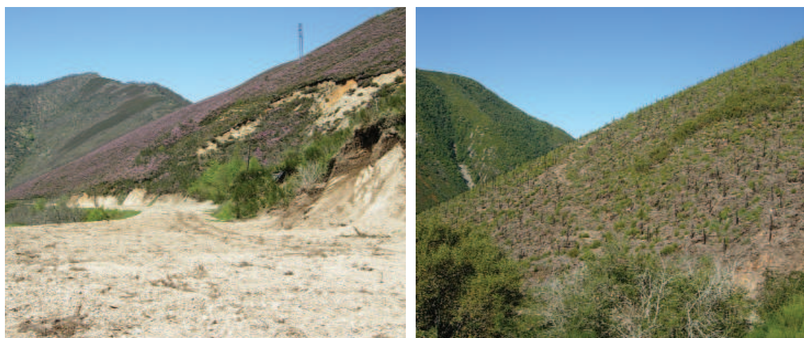
Figura 6.62. Escarificación de la antigua carretera, actualmente en desuso (izquierda) y vista de un sector en el que se llevó a cabo la repoblación forestal. Fotos: Consejería de Medio Ambiente, Ordenación del Territorio e Infraestructuras, Gobierno del Principado de Asturias.
