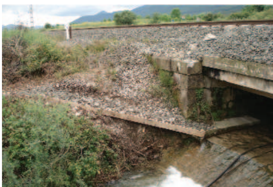
Figura 6.51. La banqueta lateral de este paso no tenía continuidad hacia el talud, por lo que se prolongó mediante una rampa de madera. Foto: GAVRN.
