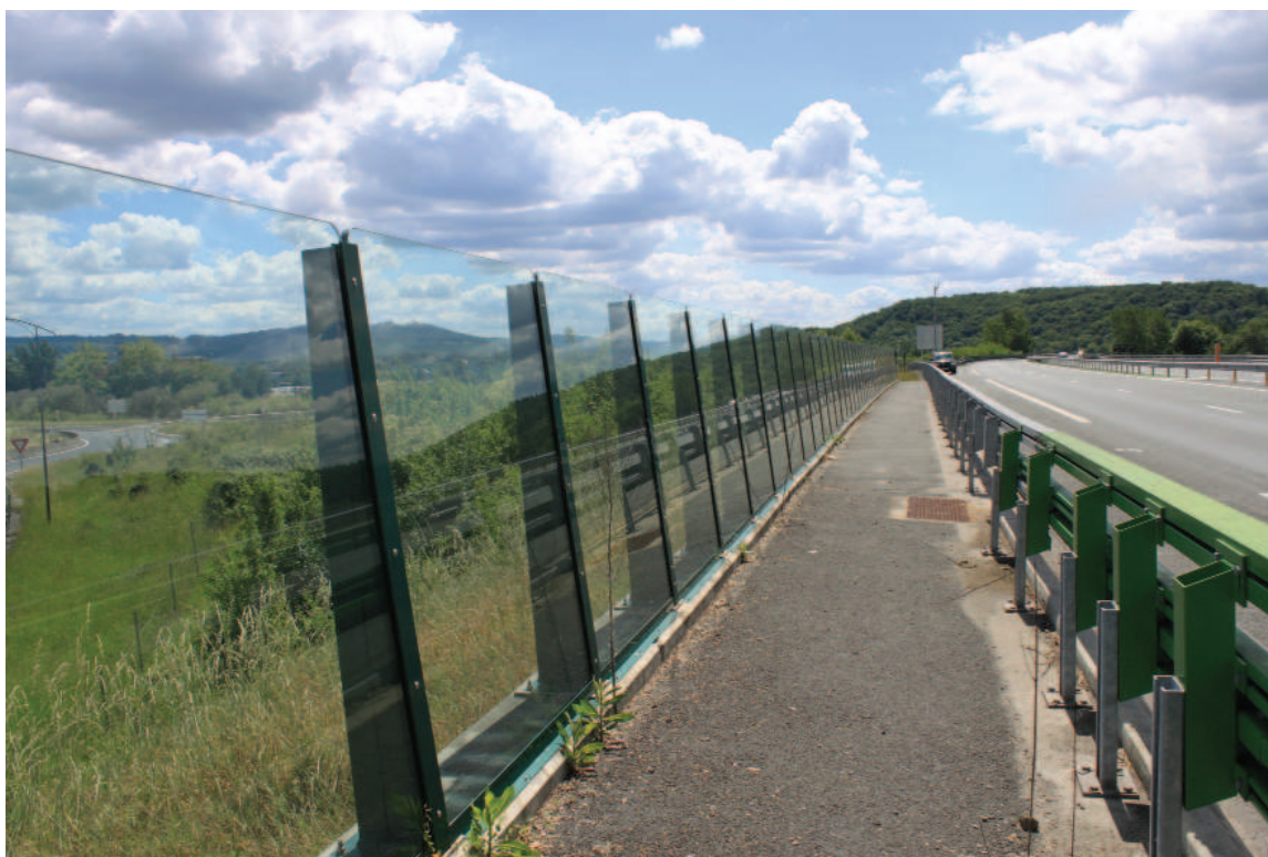
Figura 5.4. Las pantallas acústicas transparentes son una trampa para las aves que pueden impactar con ellas debido a su reducida visibilidad. Foto: Minuartia.
