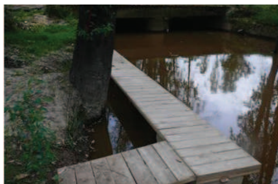
Figura 6.19. Adecuación de drenaje con banqueta lateral en Camino asfaltado. Foto: Junta de Andalucía LIFE06NAT/E/209.
