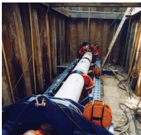
Figura 2.2. Los primeros ejemplos de actuaciones de desfragmentación en Europa consistieron en la instalación de pequeños tubos para tejones. A la izquierda se aprecia la instalación de un paso en una carretera en funcionamiento y a la derecha un tejón usando uno de los pasos. Fotos: Hans Bekker y Vereniging 'Das en Boom' (Iuell et al. 2005).
