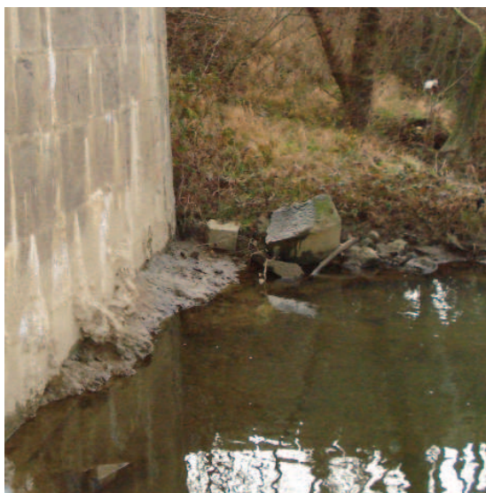
Figura 6.50. Situación previa a la adecuación del paso (imagen izquierda), con las aguas del río Arakil alcanzando el estribo del puente y rompiendo la continuidad terrestre de la orilla, y solución adoptada (imagen derecha), banqueta de hormigón adosada al estribo del puente. Fotos: GAVRN.
