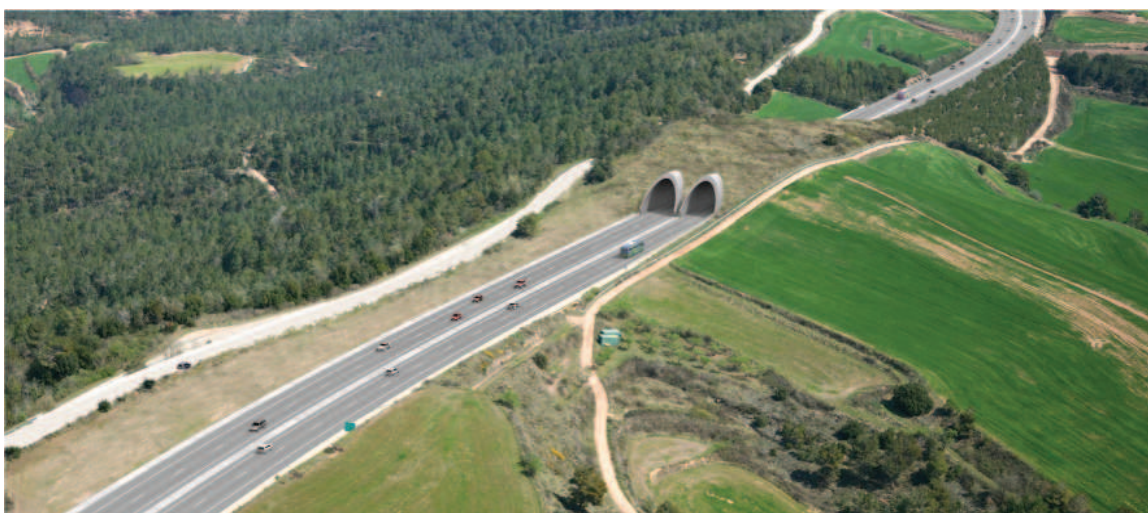
Figura 6.55. Estado original de la zona de actuación (imagen superior) y representación virtual de la carretera desdoblada y con la construcción del ecodeck. Fotos: GISA. Generalitat de Catalunya.
