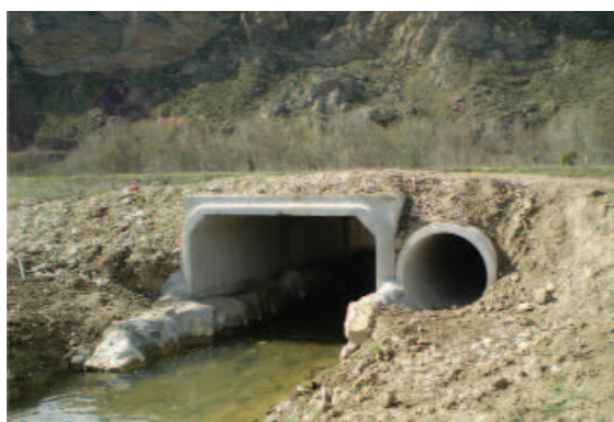
Figura 6.34. Combinación de marco prefabricado con banquetta lateral en la margen izquierda y un tubo seco en la margen derecha. Foto: GAVRN, LIFE GERVE.
