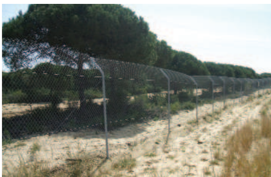
Figura 6.21. Vallado perimetral adaptado para el lince, de 3 m de altura, enterrado 50 cm, y con visera superior. Foto: Junta de Andalucía
