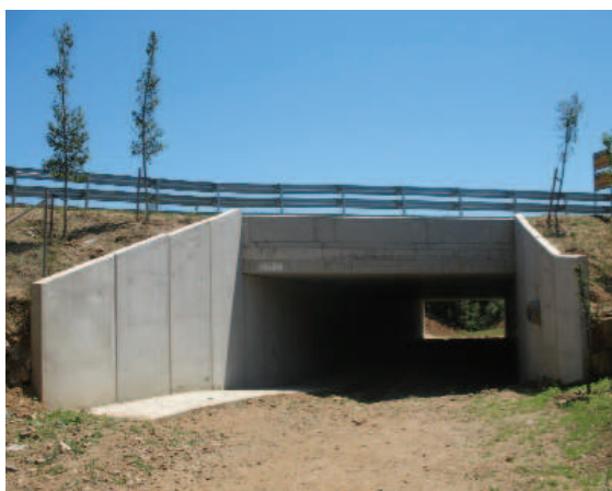
Figura 6.14. Obra de drenaje adaptada para el paso de fauna. Se conservó la base de sustrato natural, se construyó una banqueta lateral y se revegetaron adecuadamente los accesos. Foto: Minuartia.
