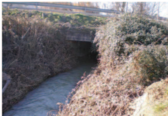
Figura 6.38. Estado de los accesos a la estructura antes de la actuación. Año 2009. Foto: GAVRN.
