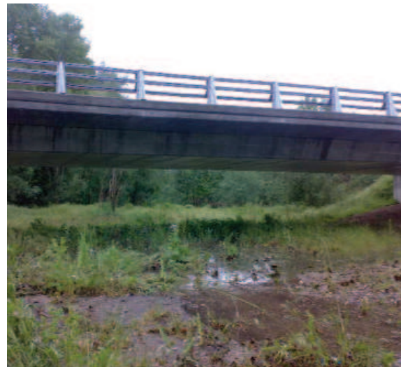
Figura 6.57. El viaducto que sustituyó a los tubos de acero corrugado aumenta de manera notable la permeabilidad de la carretera en su intersección con el corredor de la Mugueta. Fotos: Minuartia.
