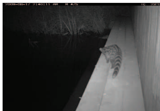
Figura 6.49. Gineta ( Genetta genetta ) cruzando el drenaje de un canal por la banquetta lateral instalada. Foto: Minuartia.
