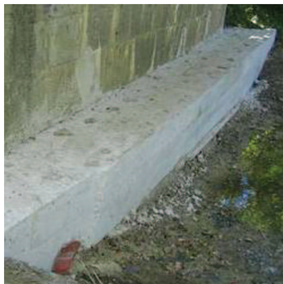
Figura 6.50. Situación previa a la adecuación del paso (imagen izquierda), con las aguas del río Arakil alcanzando el estribo del puente y rompiendo la continuidad terrestre de la orilla, y solución adoptada (imagen derecha), banqueta de hormigón adosada al estribo del puente. Fotos: GAVRN.
