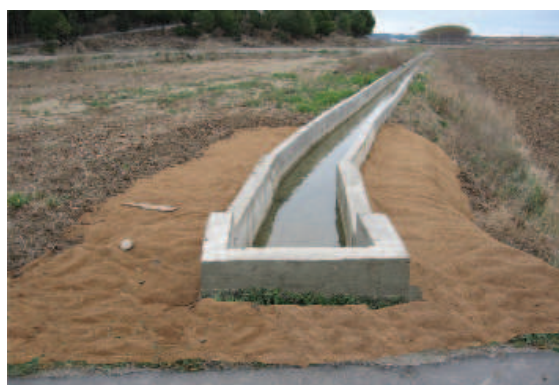
Figura 6.35. Instalación de geotextil que evita el desarrollo de la vegetación en el tramo de intersección entre la acequia y el sifón con la carretera. Foto: GAVRN, LIFE GERVE.
