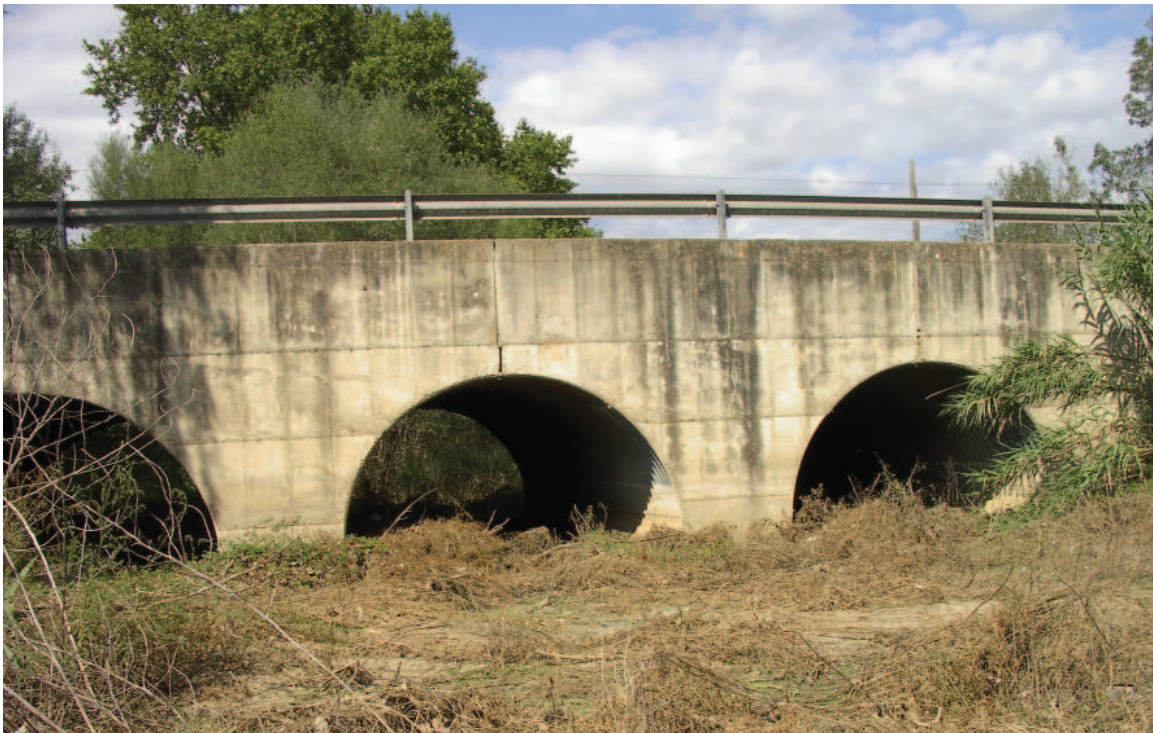
Figura 6.56. Tubos de acero corrugado bajo la antigua carretera de Castelló d'Empúries a Roses, que representaban un estrangulamiento del corredor de la Mugueta entre dos Reservas Naturales Integrales del Parque Natural de Els Aiguamolls de l'Empordà. Foto: Minuartia.
