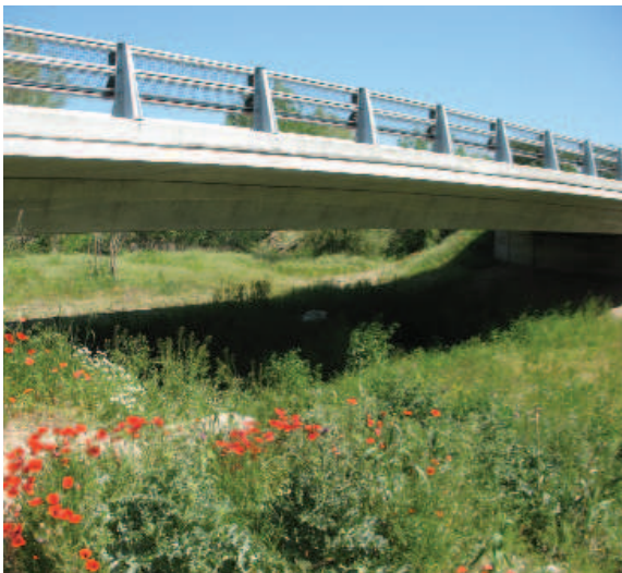
Figura 6.57. El viaducto que sustituyó a los tubos de acero corrugado aumenta de manera notable la permeabilidad de la carretera en su intersección con el corredor de la Mugueta. Fotos: Minuartia.
