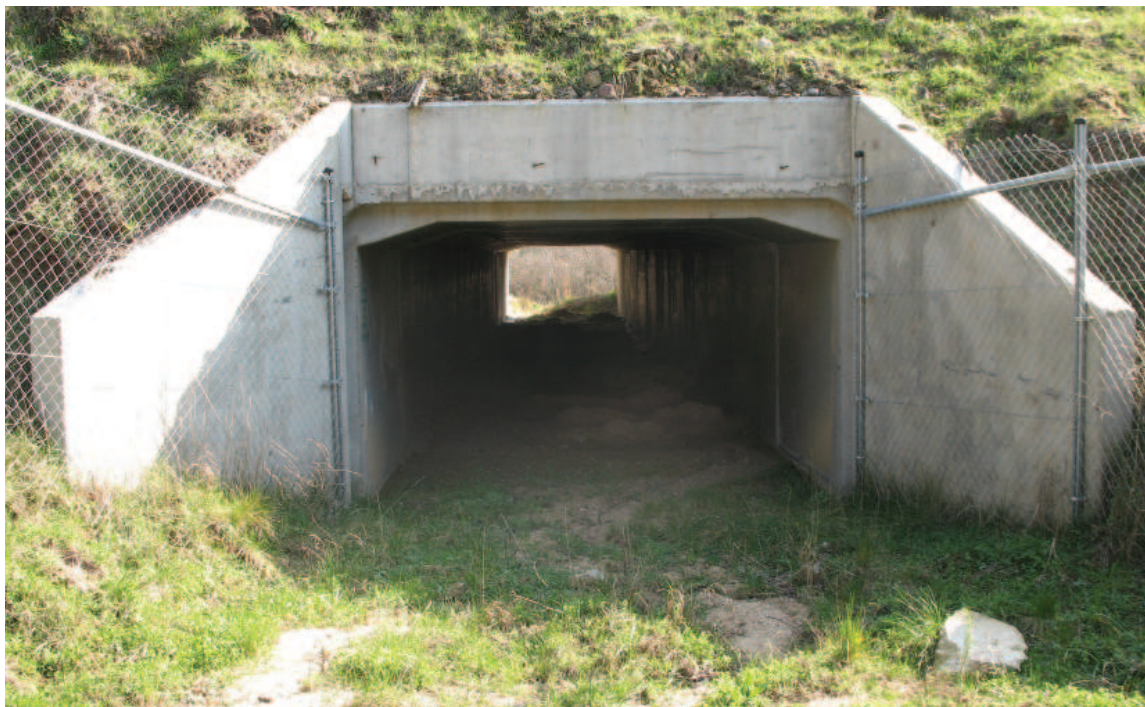
Figura 5.6. Paso inferior específico construido aprovechando el proyecto de mejora de una carretera. Foto: Minuartia.
