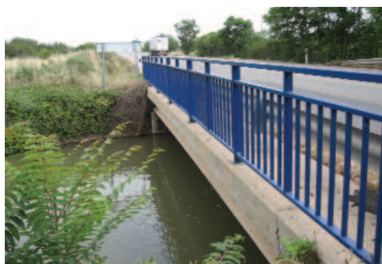
Figura 6.44. La ausencia de franjas secas en las estructuras de drenaje por las que cruzan acequias o canales favorece que los visones europeos accedan por el talud a la calzada, incrementando el riesgo de atropello. Fotos: Minuartia.
