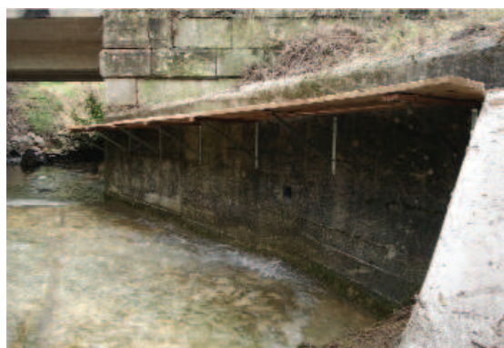
Figura 6.52. Detalle de una banqueta lateral construida en una obra de drenaje. Foto: GAVRN.
