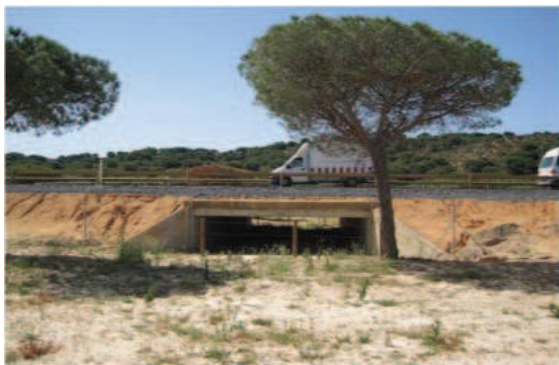
Figura 6.23. Paso inferior de reciente construcción entre Matalascañas y Mazagón. Foto: Junta de Andalucía
