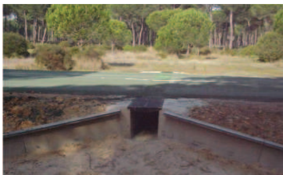
Figura 6.27. Acceso a un paso para anfibios. Foto: Junta de Andalucía.
