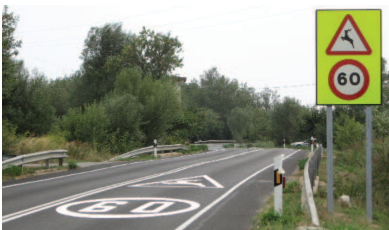
Figura 6.6. Refuerzo de la señalización instalada en uno de los Tramos de Concentración de Colisiones con Ungulados de atención prioritaria. En este Tramo se realiza un seguimiento de las colisiones para determinar la efectividad de las actuaciones implantadas. Foto: Minuartia.
