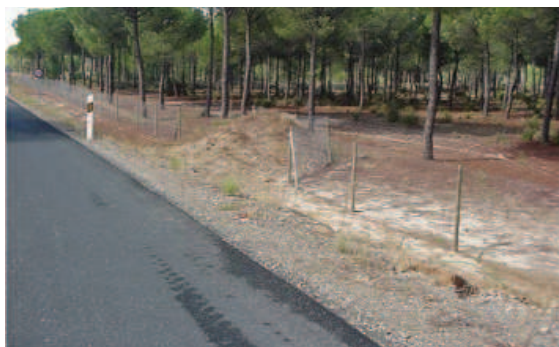
Figura 6.31. Rampas de escape, construidas mediante madera y tierra. Foto: Junta de Andalucía.
