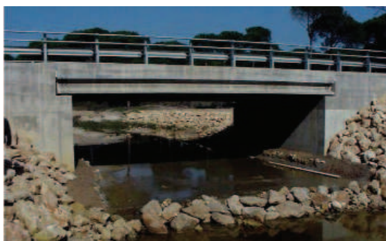
Figura 6.29. Estructura sobre un cauce con banquetas laterales y diques entre orillas. Foto: Junta de Andalucía.
