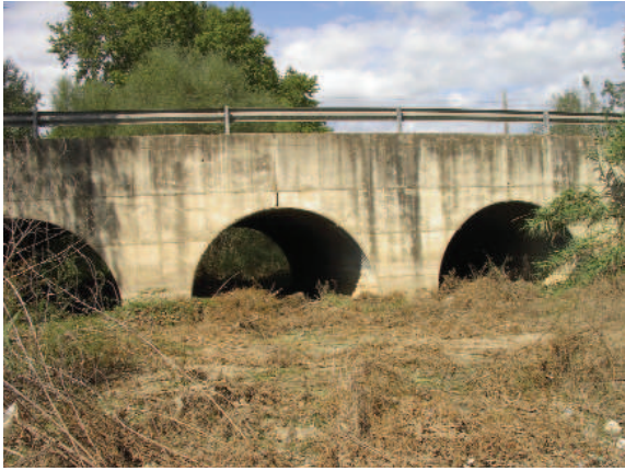
Figura 2.5. Como medida compensatoria al desdoblamiento de una carretera en el Parque Natural de Els Aiguamolls de l'Empordà (Girona), se actuó sobre otra carretera y se recuperó la funcionalidad de un corredor ecológico sustituyendo unos tubos de drenaje por un viaducto que ha permitido recuperar la continuidad de los hábitats de ribera (véase más información en el capítulo 6, Ficha 14). Fotos: Minuartia.
