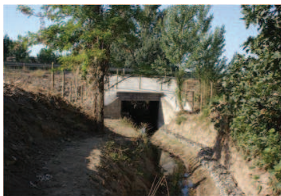
Figura 6.40. Estado de los accesos tras las obras de adecuación. Año 2009. Foto: GAVRN.
