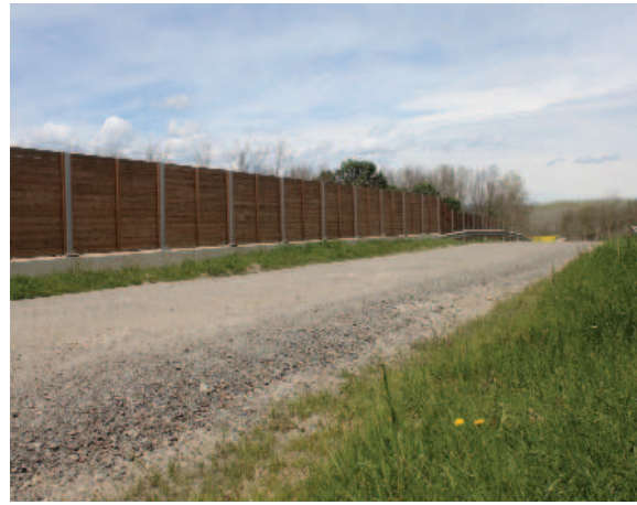
Figura 5.5. Los pasos superiores pueden acondicionarse para facilitar el paso de fauna adecuando márgenes con cobertura vegetal y con apantallamientos para evitar las perturbaciones generadas por el tráfico. Fotos: Minuartia.
