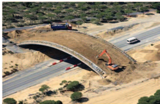
Figura 6.24. Construcción de pasos superiores. Foto: Junta de Andalucía
