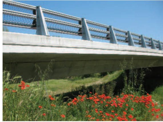
Figura 2.5. Como medida compensatoria al desdoblamiento de una carretera en el Parque Natural de Els Aiguamolls de l'Empordà (Girona), se actuó sobre otra carretera y se recuperó la funcionalidad de un corredor ecológico sustituyendo unos tubos de drenaje por un viaducto que ha permitido recuperar la continuidad de los hábitats de ribera (véase más información en el capítulo 6, Ficha 14). Fotos: Minuartia.
