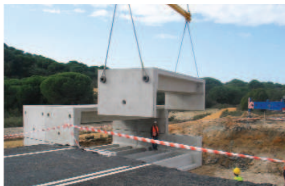
Figura 6.22. Construcción de pasos inferiores con módulos prefabricados. Foto: Junta de Andalucía
