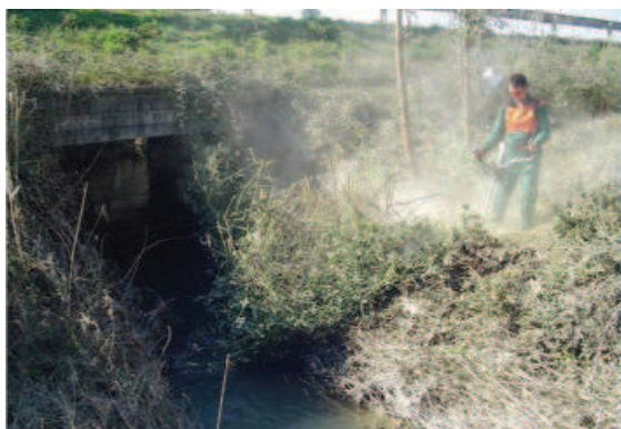
Figura 6.39. Trabajos de desbroce en los accesos a la estructura. Año 2009 Foto: GAVRN.
