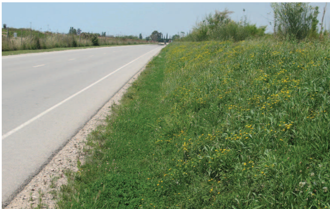
Figura 5.8. Los caballones de tierra en los márgenes de infraestructuras reducen los impactos generados por estas sobre los hábitats naturales del entorno. Foto: Minuartia.
