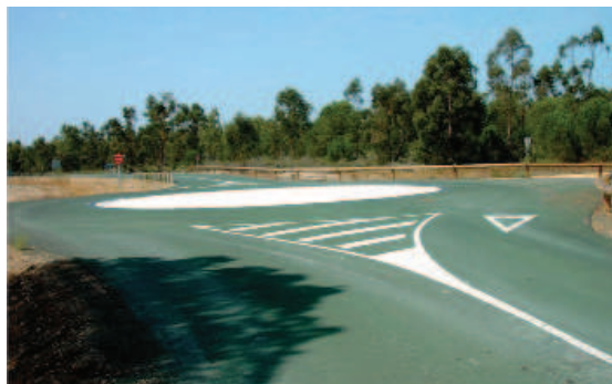
Figura 6.32. Firme coloreado y glorietas para ralentizar el tráfico. Foto: Junta de Andalucía.
