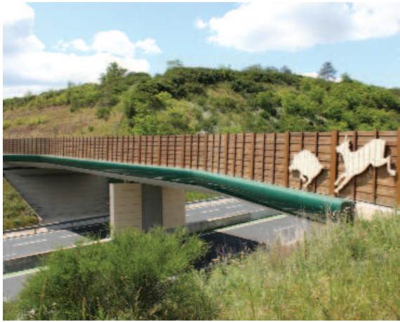
Figura 5.5. Los pasos superiores pueden acondicionarse para facilitar el paso de fauna adecuando márgenes con cobertura vegetal y con apantallamientos para evitar las perturbaciones generadas por el tráfico. Fotos: Minuartia.
