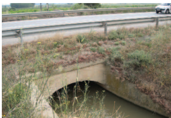
Figura 6.44. La ausencia de franjas secas en las estructuras de drenaje por las que cruzan acequias o canales favorece que los visones europeos accedan por el talud a la calzada, incrementando el riesgo de atropello. Fotos: Minuartia.
