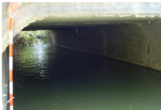
Figura 6.33. Obra de drenaje adecuada para el visón europeo en el proyecto LIFE GERVE, antes y después de la actuación: colocación de banquetas laterales a lo largo de la obra de drenaje. Fotos: GAVRN.
