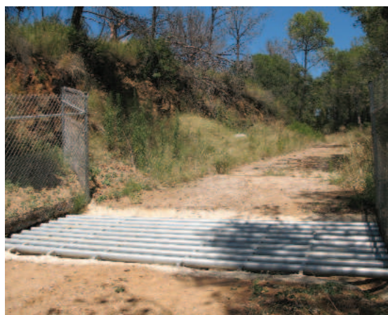
Figura 6.15. Para evitar el acceso de los ungulados a la vía, se propuso la instalación de cerramiento perimetral en todos tramos con desdoblamiento previsto y de pasos canadienses en los accesos de los caminos a la carretera. Foto: Minuartia.
