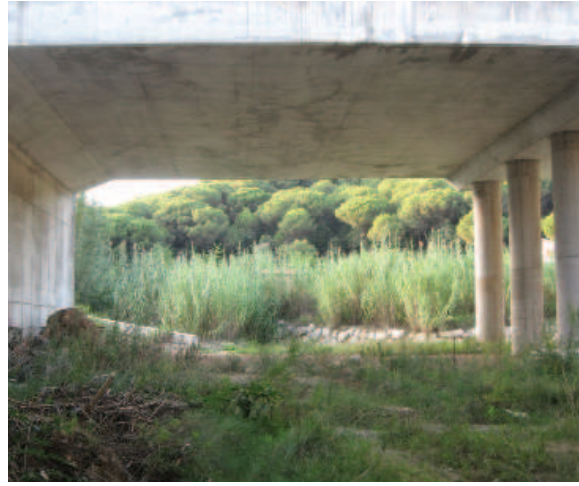
Figura 5.7. Con la construcción de la LAV junto a la línea de ferrocarril convencional fue posible la sustitución de una pequeña bóveda localizada en un corredor ecológico (izquierda) por un paso de fauna de grandes dimensiones bajo ambas infraestructuras (derecha). Fotos: Minuartia.
