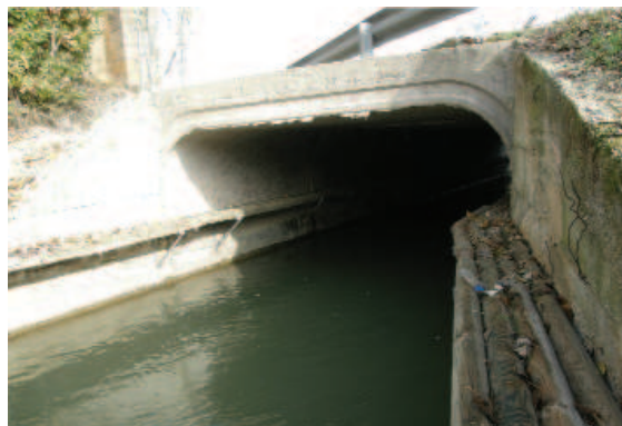
Figura 6.33. Obra de drenaje adecuada para el visón europeo en el proyecto LIFE GERVE, antes y después de la actuación: colocación de banquetas laterales a lo largo de la obra de drenaje. Fotos: GAVRN.
